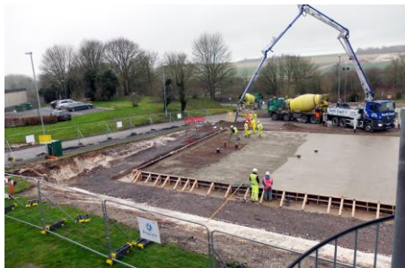
Concrete Pour At Bulford
