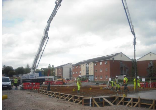
Concrete slab pour at Tidworth
